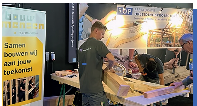
Een leerling van Bouwmensen aan het werk in de ROP-stand
